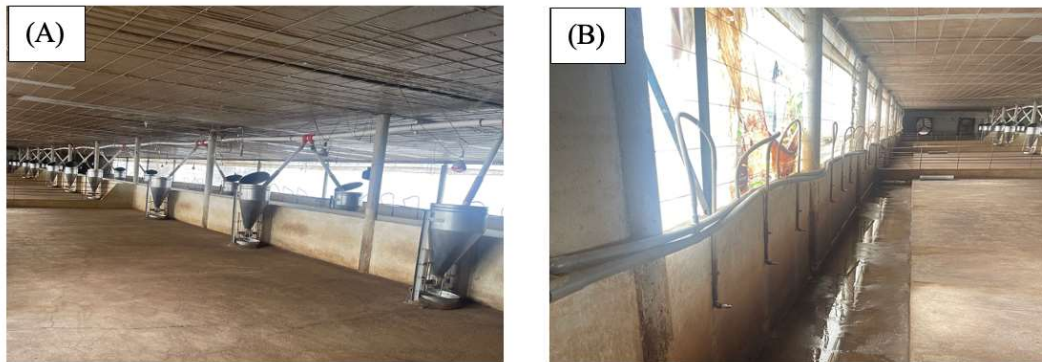
Hình 3.7 (A) Hệ thống cung cấp thức ăn, (B) nước uống tự động cho heo
